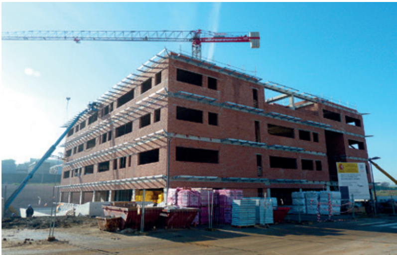
Figura 6. Construcción del edificio de IBBTEC. Estado de la obra en 2011.
