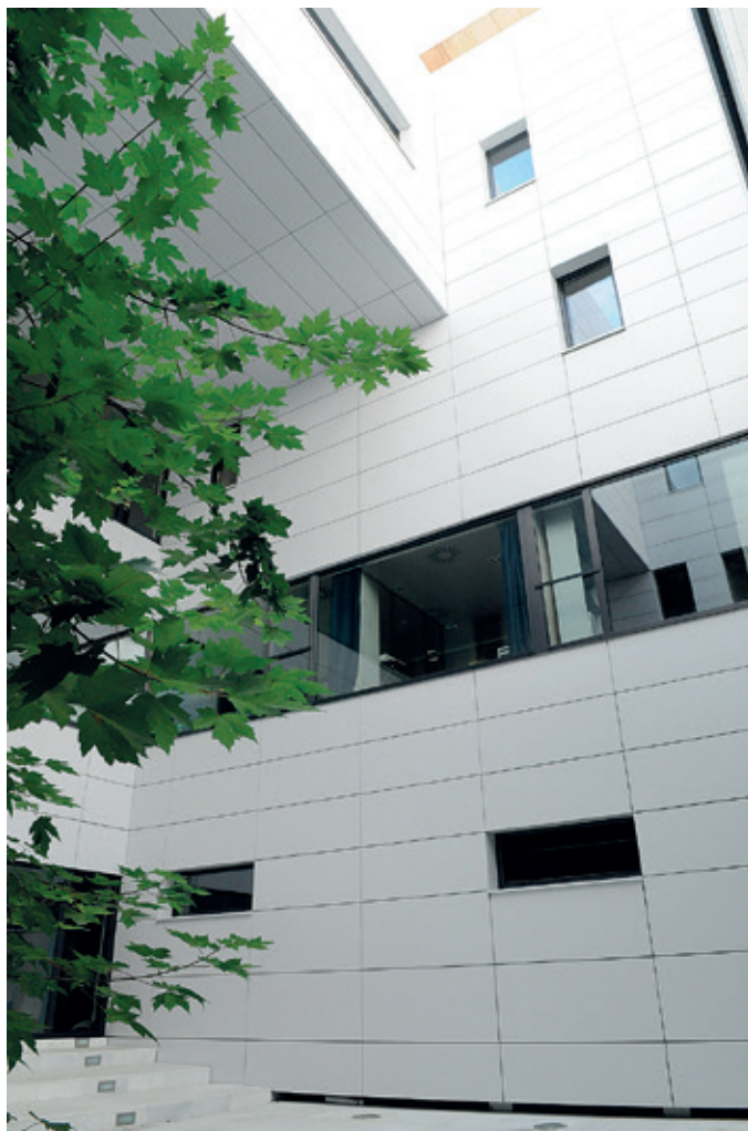
Figura 7. Patio interior del edificio del IBBTEC.
