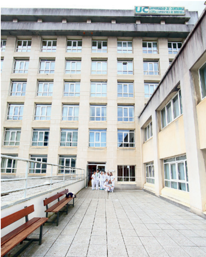
Figura 4. Edificio de la Facultad de Enfermería, años 90 (entonces aún Escuela Universitaria). © Agustín Oterino.
