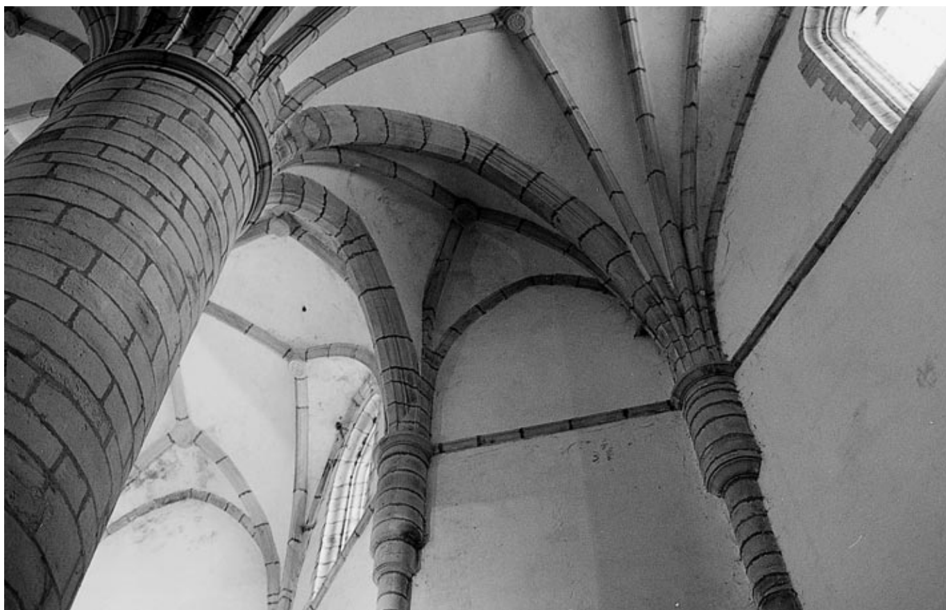
Solución para la transición entre la cabecera y el cuerpo de naves.
