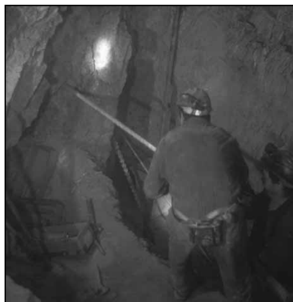
Figura 1. Trabajos de perforación con potro eléctrico roto-percutor para la introducción de anclaje.
