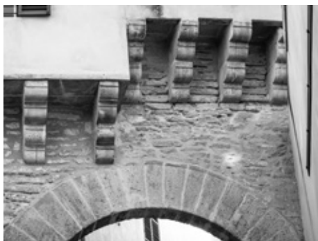
Fig. 6. Detalle de la mampostería del arco. Foto: Jaume Gual.
