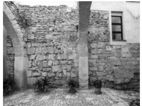
Fig. 5. Restos de la muralla aparecidos junto al lateral sud-oeste del arco, junto a Can Bordils. Foto: Jaume Gual.
