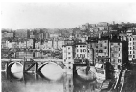
Fig. 2. Girard Desargues, edificio en el Pont du Change (Lyon) (fotografía ant. 1843).
