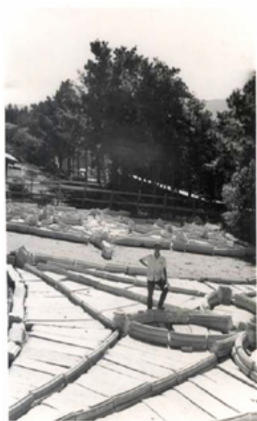
Fig. 6. Construcción del Parador de Baiona. Desmonte piedra a piedra de la bóveda procedente del convento de San Francisco/Palacio de Eluayen. AGA: 28362-005.
