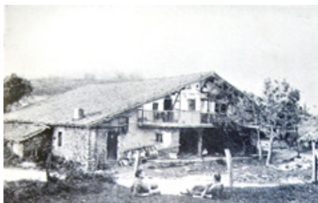
Fig. 6. Caserío Gerekiz, en Morga (Vizcaya).
