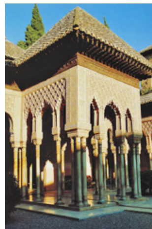
Fig. 4. Palacio de los Leones. Pabellón oriental.
