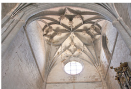
Fig. 6. Bóvedas de la iglesia de Santa María del Campo. Simón de Colonia.
